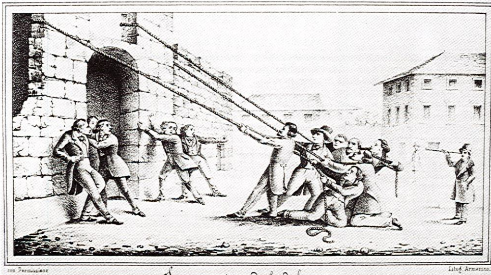
La demolizione della porta San Giovanni. Litografia da O canociale de Savon-a, Almanacco per l'anno bisestile 1844.
