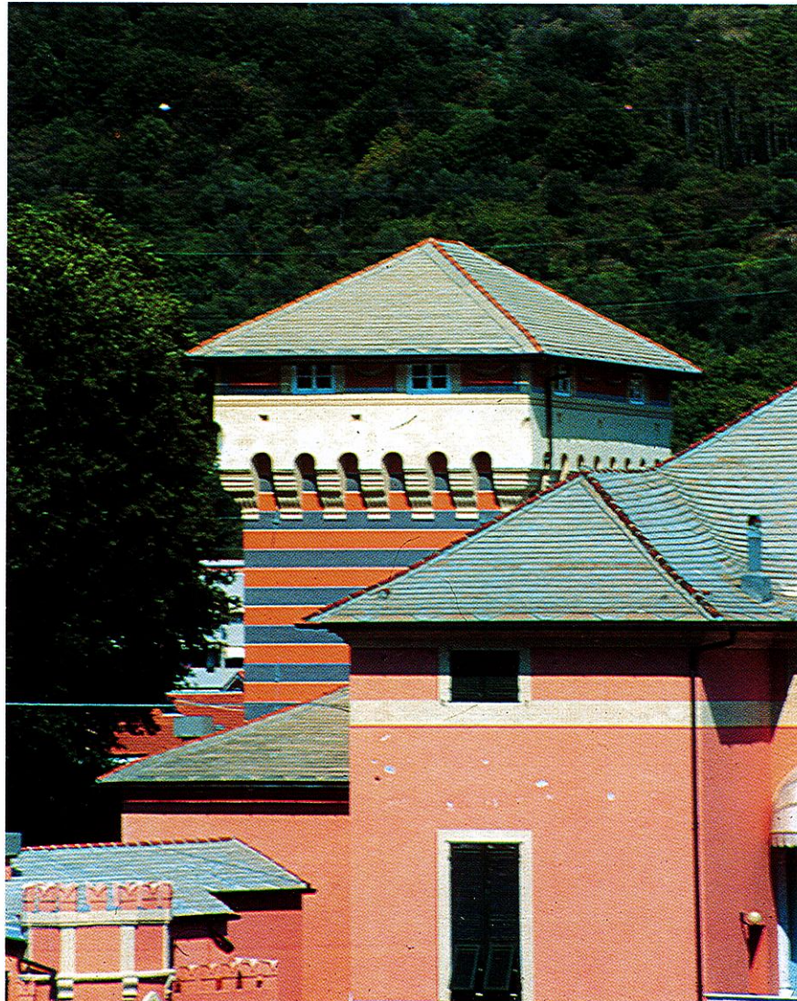
Castello Imperiale (via Nazionale al Piemonte). In eccellente ubicazione strategica all'incrocio delle maggiori arterie tra Savona e l'entroterra subalpino, più residenza nobiliare che arnese di guerra, l'elegante e monumentale edificio in origine palladio ghibellino, ristrutturato nel secondo '500 con influenze "alessiane", all'inizio degli anni '90 è stato accuratamente restaurato. Vi si conservano affreschi attribuiti a Ottavio Semino (posteriori al 1565) e altri di Raffaello Resio (sec. XIX-XX).
