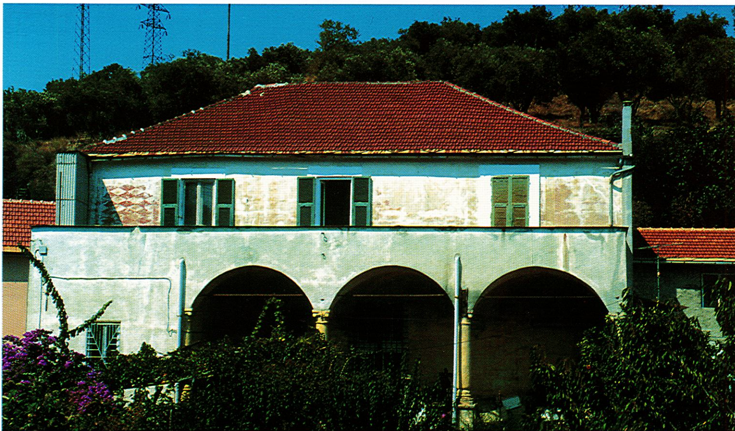
Casa rurale "La Gastodenga" (via Gastodenga) (erronea la C iniziale). Sorge in un estremo superstite lembo dell'ambiente contadino-borgale suburbano. La costruzione di dignitoso aspetto "rinascimentale", con portico e locali a volta databili ai secoli XV-XVI, dispone di uno snello porticato sul quale prospettato un ingresso e una finestra a bifora architravata.
