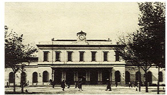
Il classico prospetto della stazione da piazza del Popolo.
