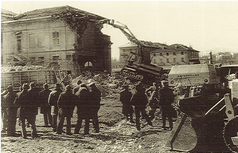
Febbraio 1980: le ruspe demoliscono la vecchia stazione. Gruppi di savonesi assistono quasi increduli.
