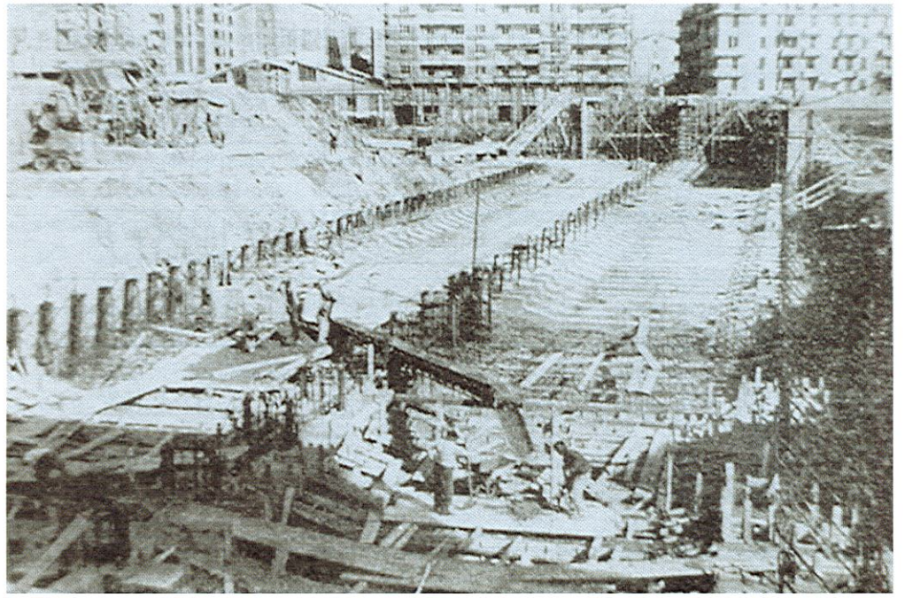
Lavori di costruzione di Savona Mongrifone.
