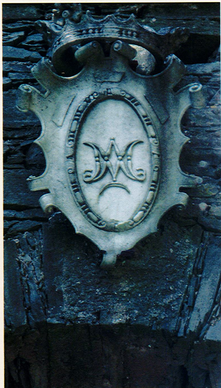
Ca' di Ferrè, Santa Maria Maddalena, particolare della facciata.
