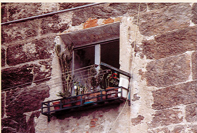
Particolare della Torre su piazza Salineri.
