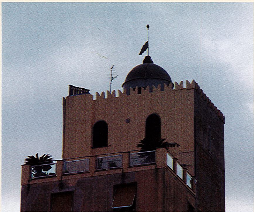
Sommità della Torre Salineri.
